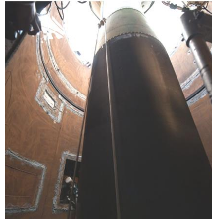
Un ICBM Minuteman III en cours d'installation dans son silo
